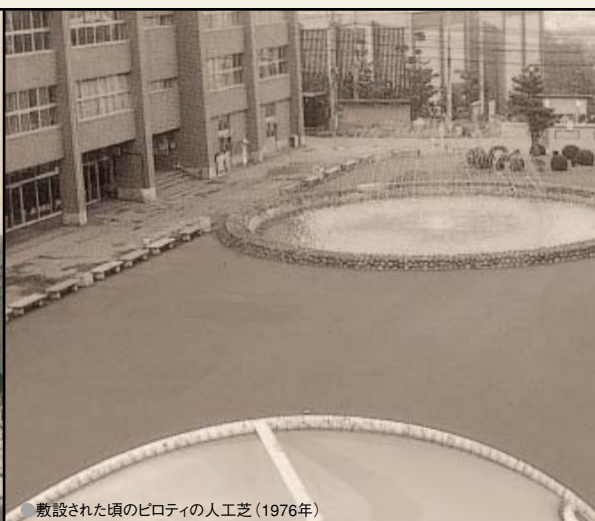
●敷設された頃のピロティの人工芝(1976年)
