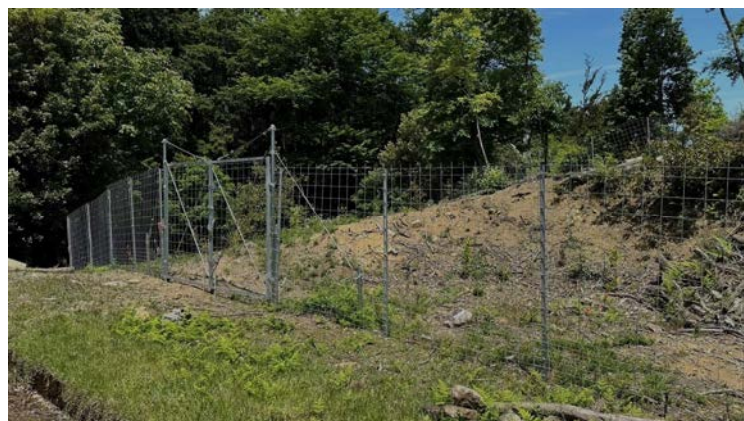
設置されているフェンス
