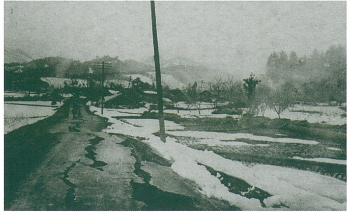
資料：【丹後大震災実況】「口大野驛ト峯山間ノ道路斷層」
