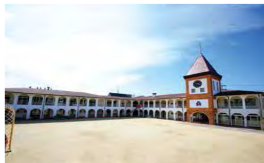
すみれ幼稚園（京都市山科区）
