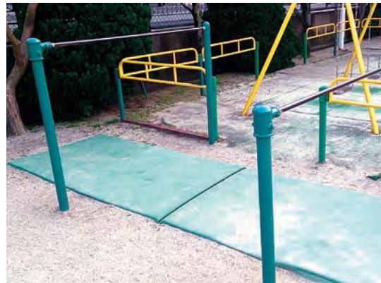
危険な箇所の改修例 (鉄棒マット)
