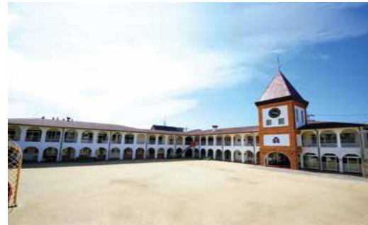
すみれ幼稚園（京都市山科区）
