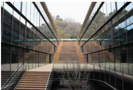
北棟・南棟間の大階段（外観）
