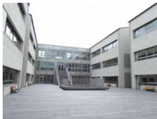
2階デッキテラス
