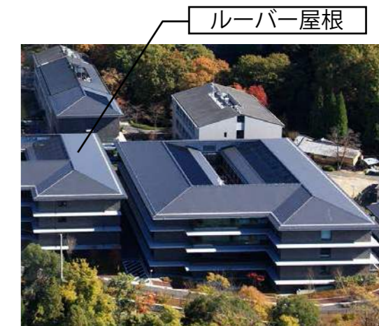
(既存14号館俯瞰写真)
