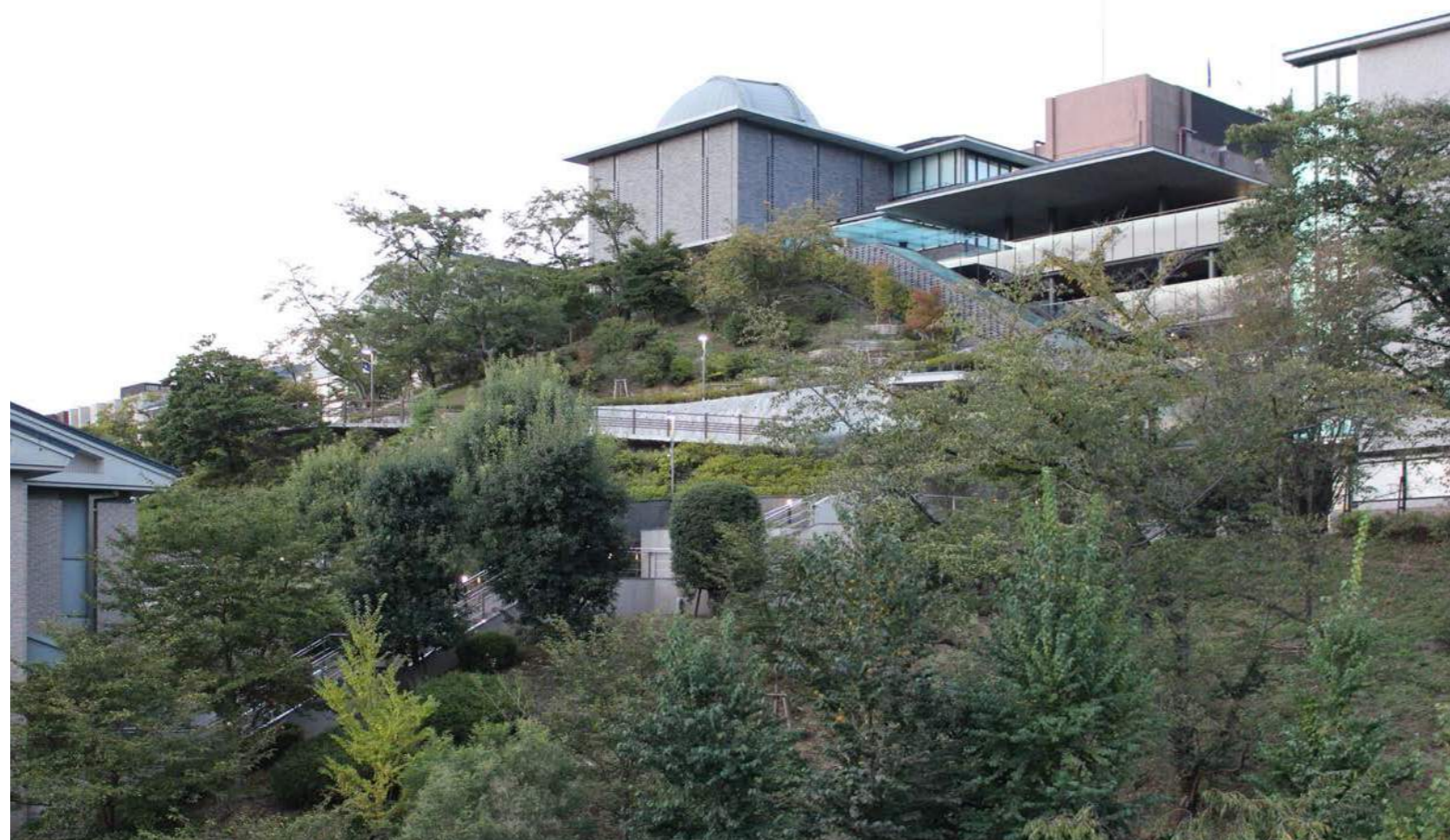
外装仕上げの様子 寄棟屋根:金属板葺き 外壁:レンガ(既存天文台)
