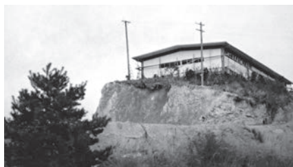
建設工事中の仮図書館（のちの学生休憩室） （昭和39年）
