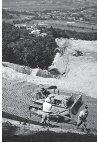
校舎建設敷地整地工事（昭和39年）
