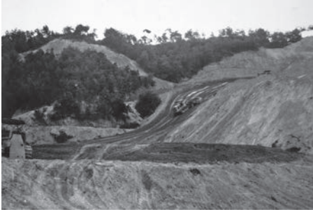
校舎建設敷地整地工事（昭和39年）
