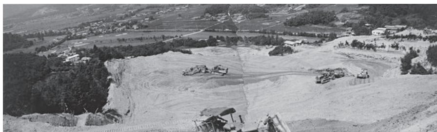
校舎建設敷地整地工事（昭和39年）
