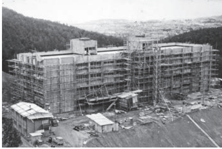
建設工事中的の本館（昭和39年）
