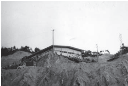
建設工事中の仮図書館(昭和39年、のちの学生休憩室)
