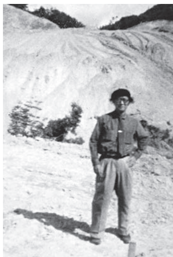
校舎建設敷地整地工事現場における 荒木俊馬（昭和39年）
