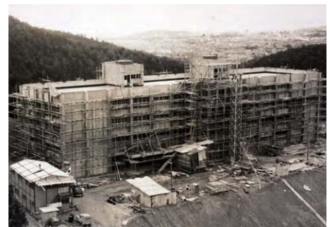
建設中の本館 (昭和39年11月)
