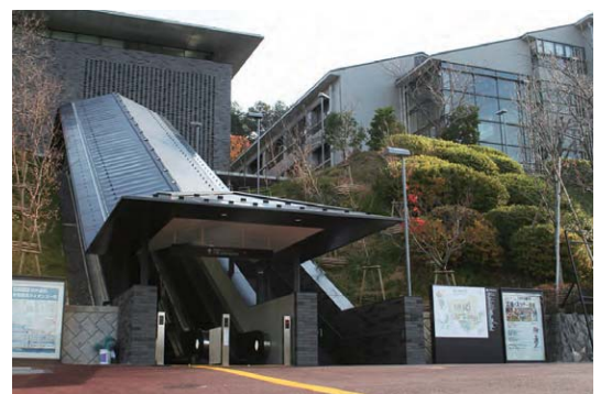
万有館前エスカレーター (平成25年9月4日竣工)
