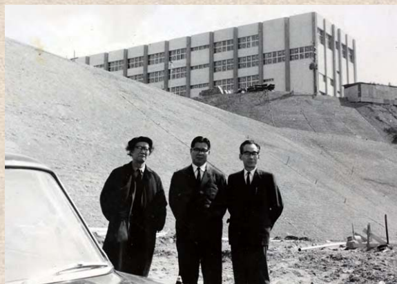
開学直前、大学建設現場視察の様子
