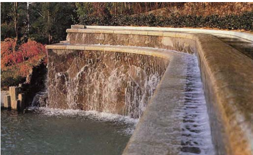
清見の滝 (昭和59年10月31日竣工)
