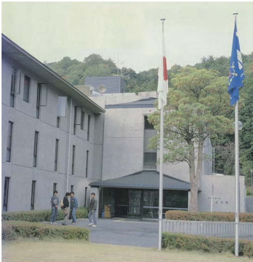
新追分寮 (昭和57年3月5日竣工)
