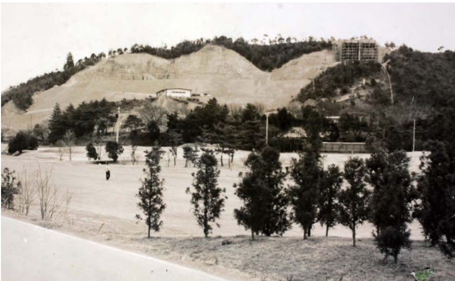
建設中の本山キャンパス全景 (昭和39年11月)
