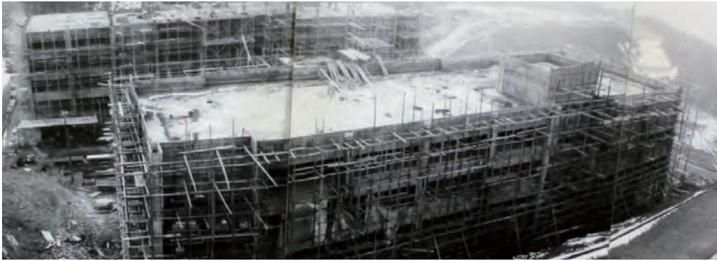
建設工事中の2、3号館 (昭和41年)
