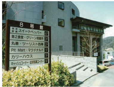
増築竣工した8号館 (平成12年3月15日竣工)
