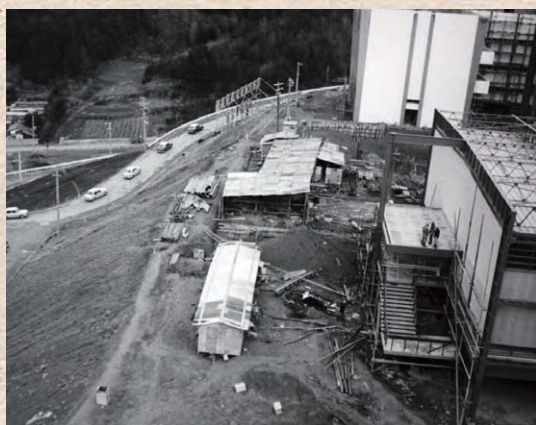
開学後、1号館建設中の学内風景
