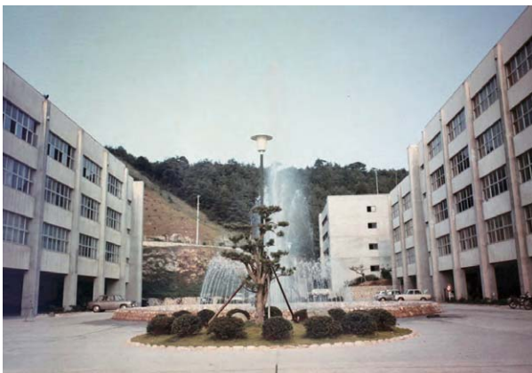
完成間もないころのピロティ (昭和44年ごろ)
