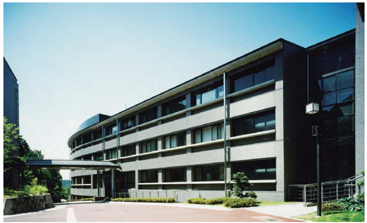
第4研究室棟 (平成14年3月29日竣工)
