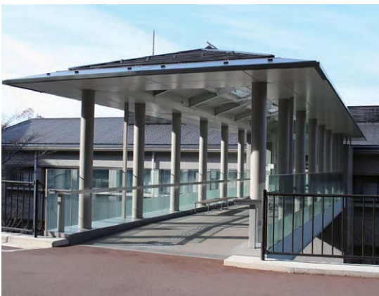
第2実験室棟渡り廊下 (平成25年3月21日竣工)
